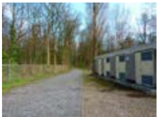
514 1981 Transformatorgebouw Gebied 6: Beproevingengebied
