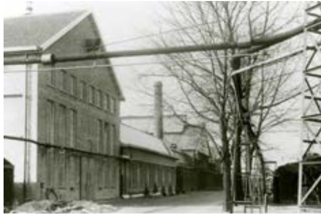
De perserij voor projectielen en het zandreinigingsgebouw (gebouwen 72 en 333), omstreeks 1940. Rechts is een deel van het netwerk van bovengrondse leidingen. [NIMH]
