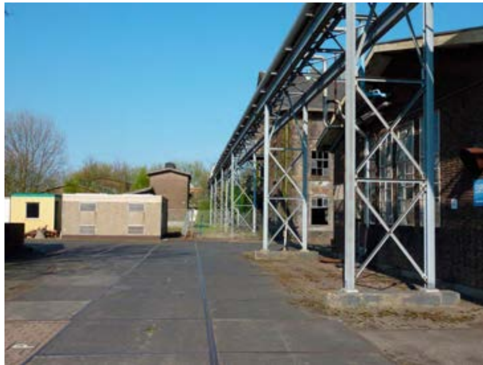
De hoofdstructuur en het buizenstelsel, ter hoogte van gebouw 14. Vanaf hier lopen de stoomleidingen door naar het Ketelhuis (gebouw 218), de hoofdstructuur buigt af naar rechtsom.
