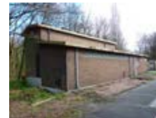
325 1936 - 1941 Transformatorgebouw Gebied 5: Productie wapens
