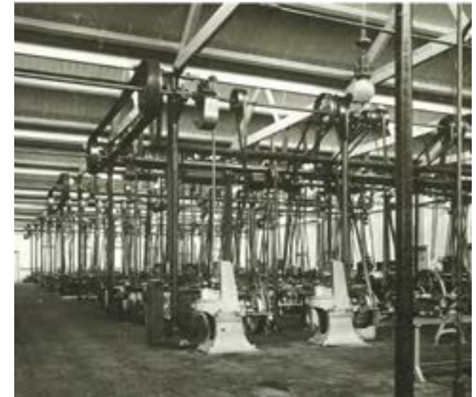
De fabriekshal van de patronenfabriek (voorheen gebouw 20), 1898. Het terrein van de Artillerie Inrichtingen werd voorzien van de modernste voorzieningen: de machines werden aangedreven door stoom en bijna elk gebouw was aangesloten op riolering, gas- en waterleiding. [Nägele, 1979]
