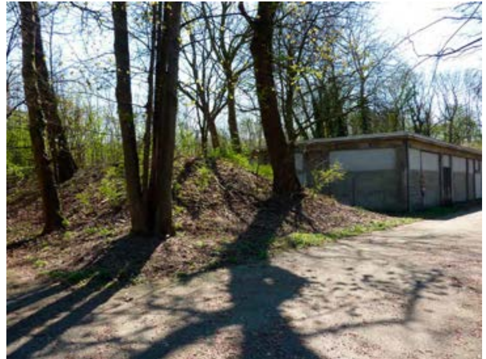
Sectorpark Zaandam: munitiemagazijnen omgeven door aarden wallen met beplanting (zowel de gebouwen als de wallen zijn rijksmonument).
