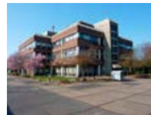
504 1981 Kantoorgebouw directie Gebied 5: Productie wapens
