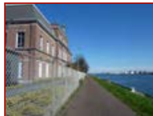
41 Rijksmonument 1897 - 1900 Bureelgebouw munitiefabriek Gebied 1: Waterfront formeel
