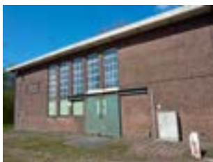
275 1929 Gasmaskersgebouw, later instructiegebouw Gebied 2: Waterfront informeel
