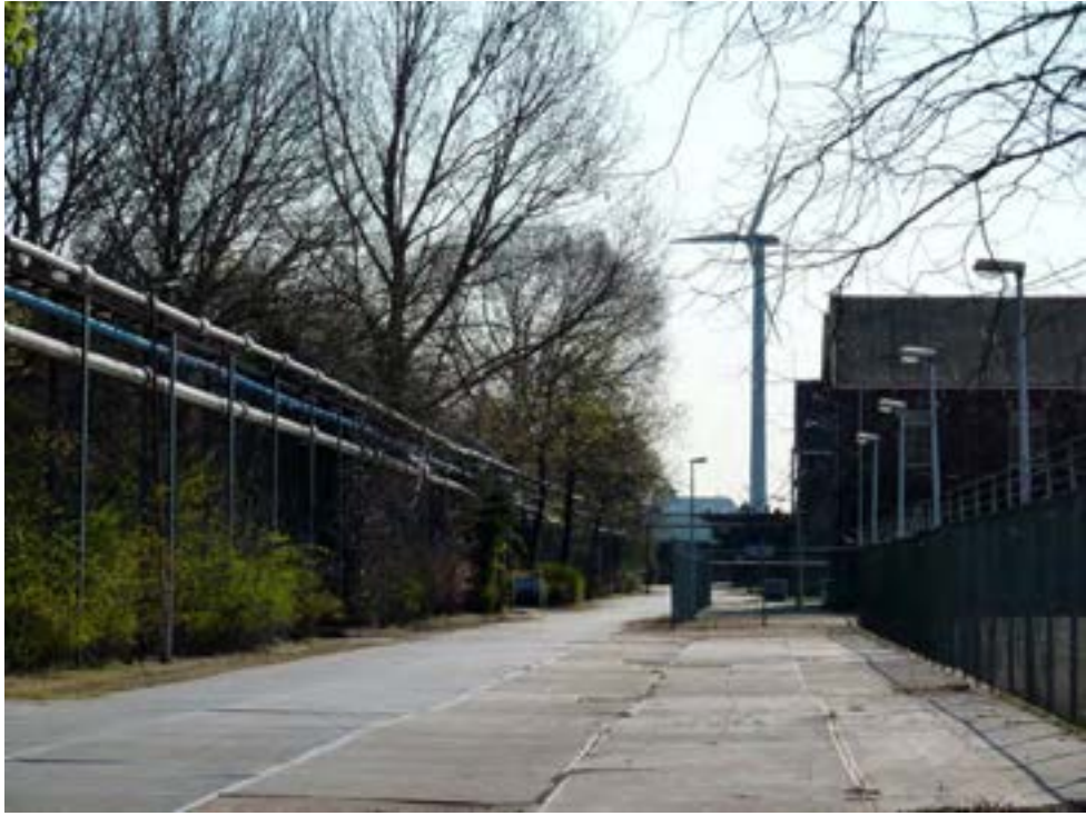
Lange zichtlijn van de hoofdstructuur dwars door het gebied (oost-west). Links het bovengrondse buizenstelsel en rechts gebouw 43.
