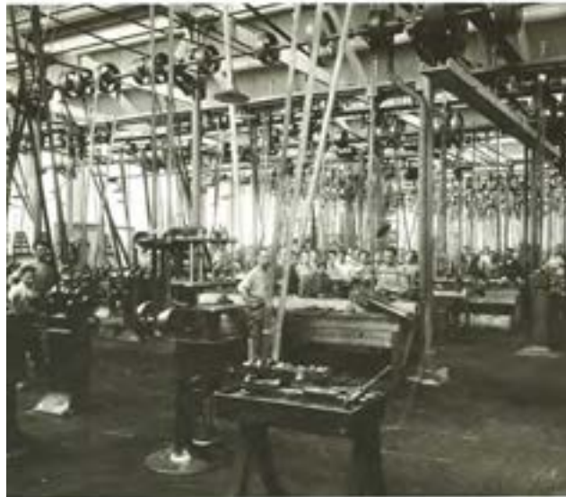
De werkplaats van de wapenfabriek (voorheen gebouw 1), 1898. De drijfriemen die de draaibanken aanstuurden, werkten op stoom. [Nägele, 1979]
