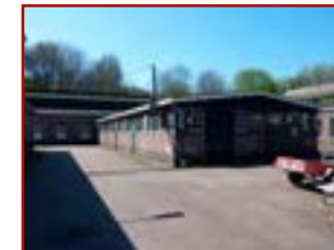
A9 Rijksmonument 1916 - 1921 Was- en kleedlokaal met magazijn Gebied 7: Sectorpark en loodsen AVP
