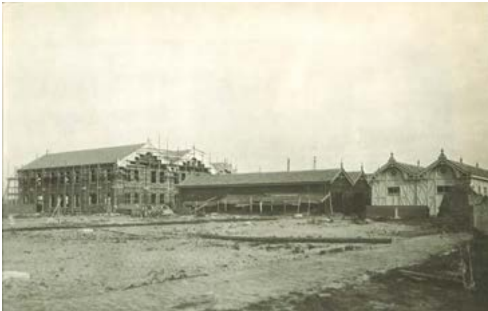
Bouwwerkzaamheden op het Hembrugterrein, 1895. [Nägele, 1979]
