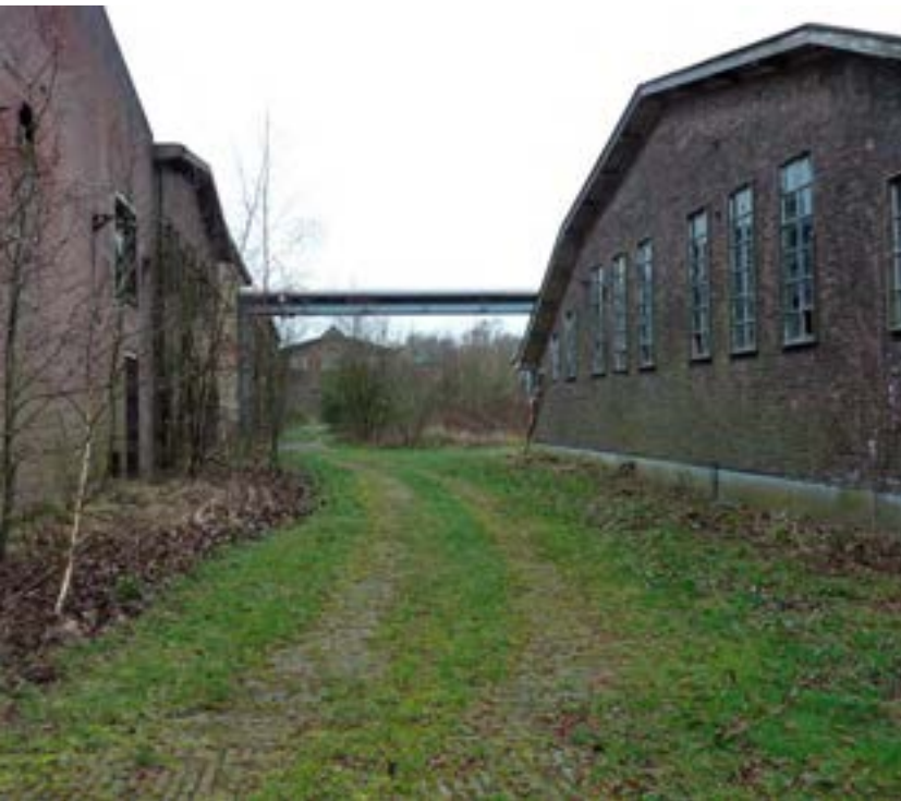
In het zuidelijk deel van dit gebied liggen de gebouwen los in het stedelijk groen en zijn van een kleinere schaal dan in het noordelijk deel. Het buizenstelsel van de stoomleidingen eindigt bij gebouw 218 (linksachter).
