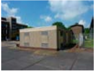
510 1979 Transformatorgebouw Gebied 5: Productie wapens
