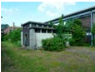
314 Bouwjaar onbekend Toiletgebouw Gebied 5: Productie wapens
