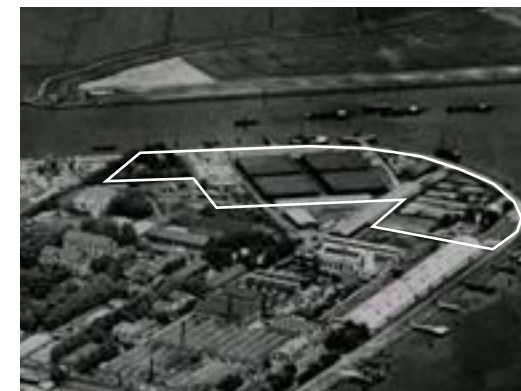
Gebiedseenheid 2, 1924. Kenmerkend is dat het gebied open en ruimtelijk was opgezet, met vier grote loodsen evenwijdig aan het Zijkanaal G (gesloopt in de jaren tachtig). [NIMH]
